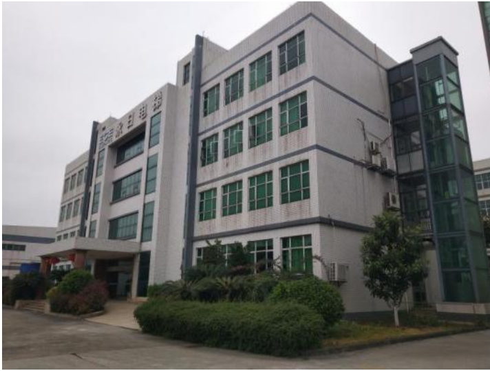
项目西面：广州永日电梯有限公司办公楼
