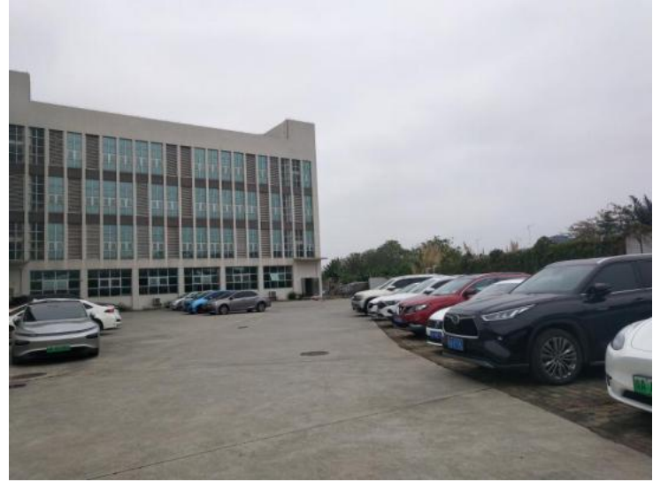
项目东面：停车场
