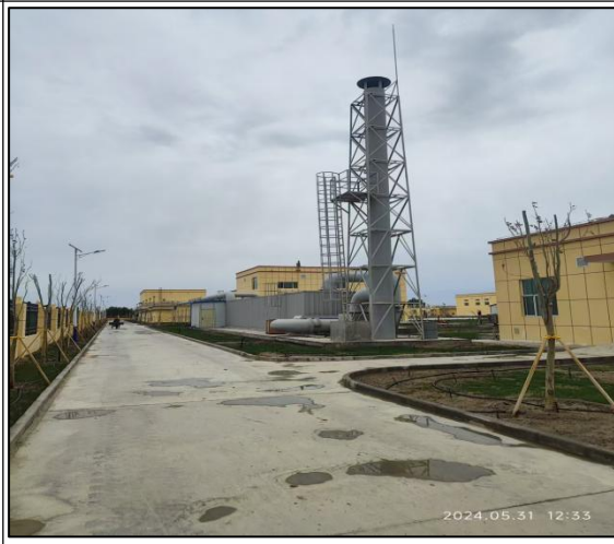
生物除臭装置废气排气筒
