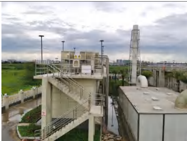
细格栅及曝气沉砂池（废气密闭收集）
