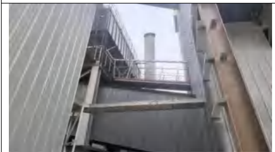
一筛布袋除尘器及排气筒
