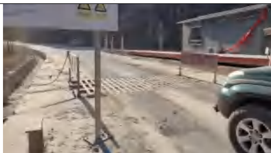
车辆冲洗平台
