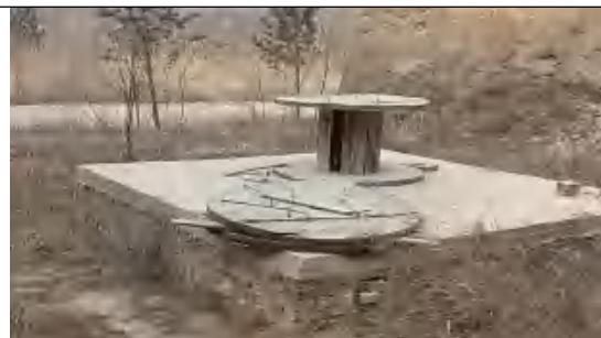
初期雨水收集池
