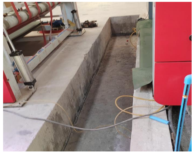
照片 4：印刷设施清洗废水收集池
