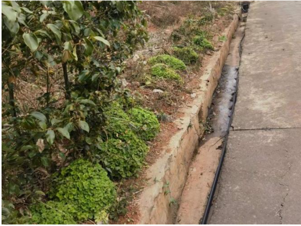
照片 7：园区雨水沟
