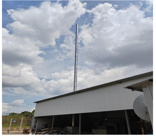
照片 2：35m 锅炉烟囱
