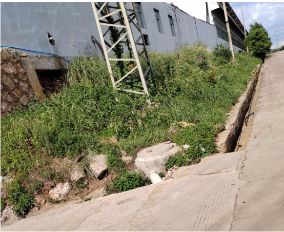
照片 9：博杰园区内化粪池
