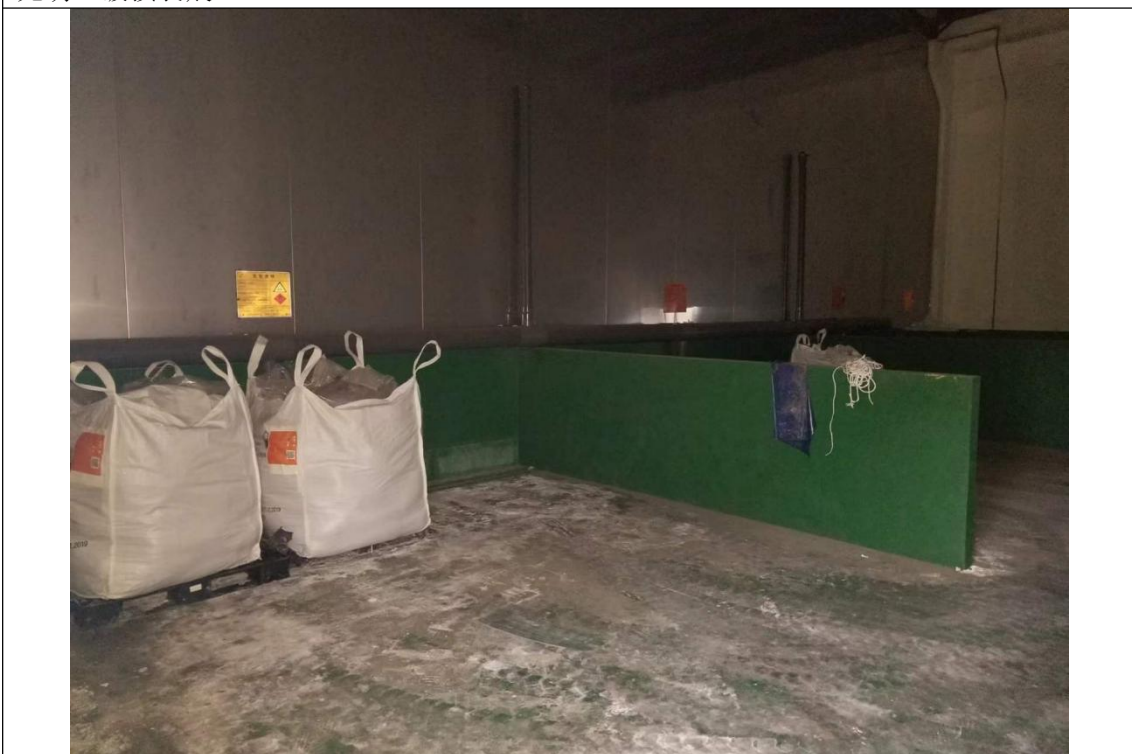
危废仓库：危废仓库存储的危险废物会对土壤和地下水产生污染，现场踏勘显示地面均已硬化，并有防水防渗涂层，地面完好无破损裂痕。
