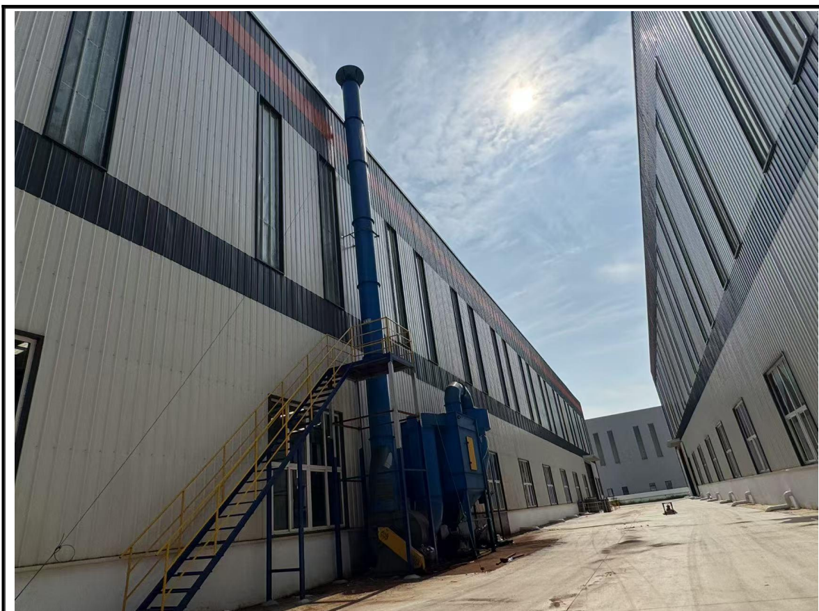
图7-2 废气处理设施
