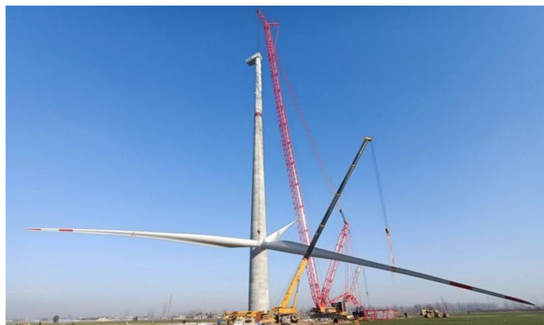
图 2-3 整机吊装
