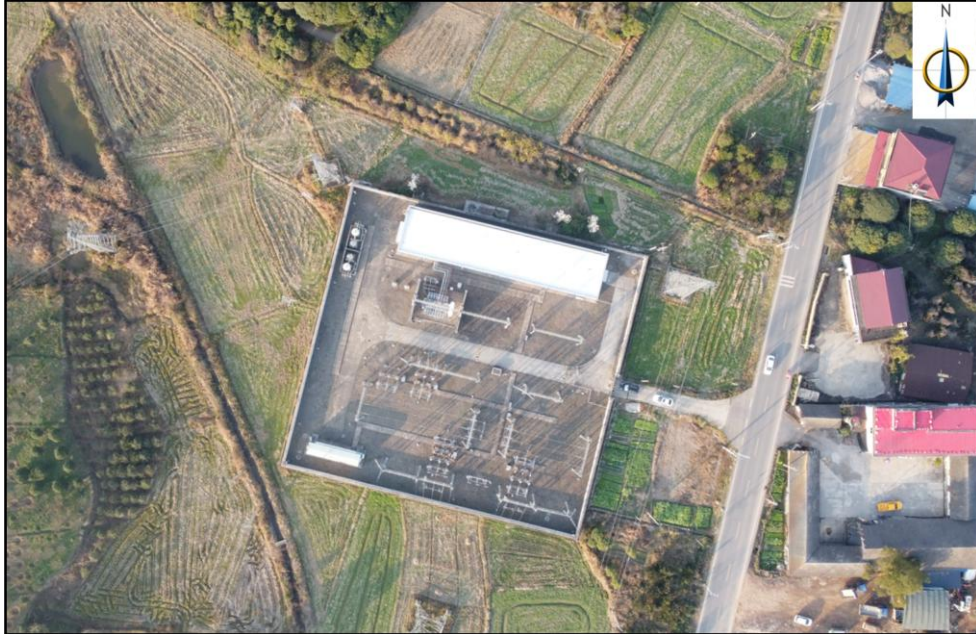
图 3-3 渡口 110kV 变电站周围环境现状
