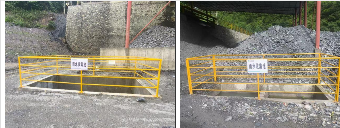
1715m 雨水收集池
