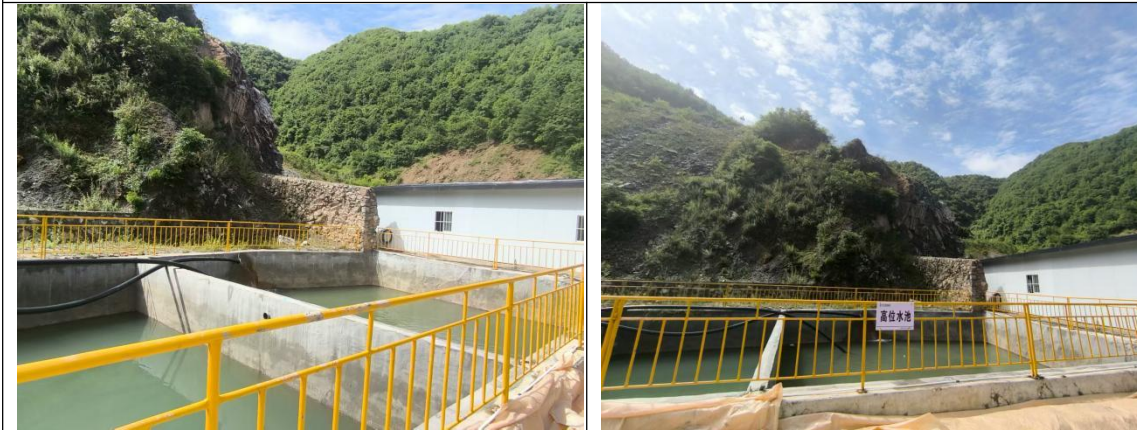
矿井废水处理站
