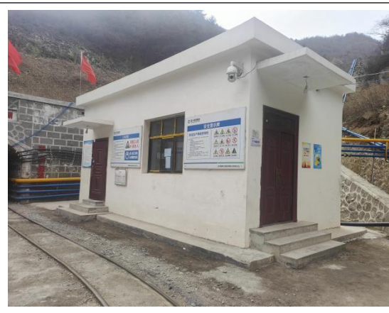
1715m 主平硐监控室
