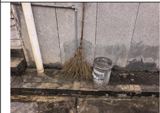
站内垃圾收集装置
