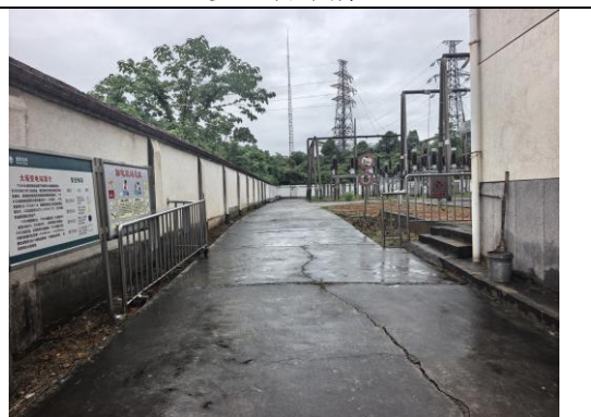
站内道路硬化
