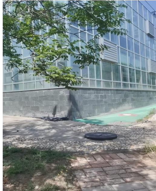
图2 生活污水排放口
