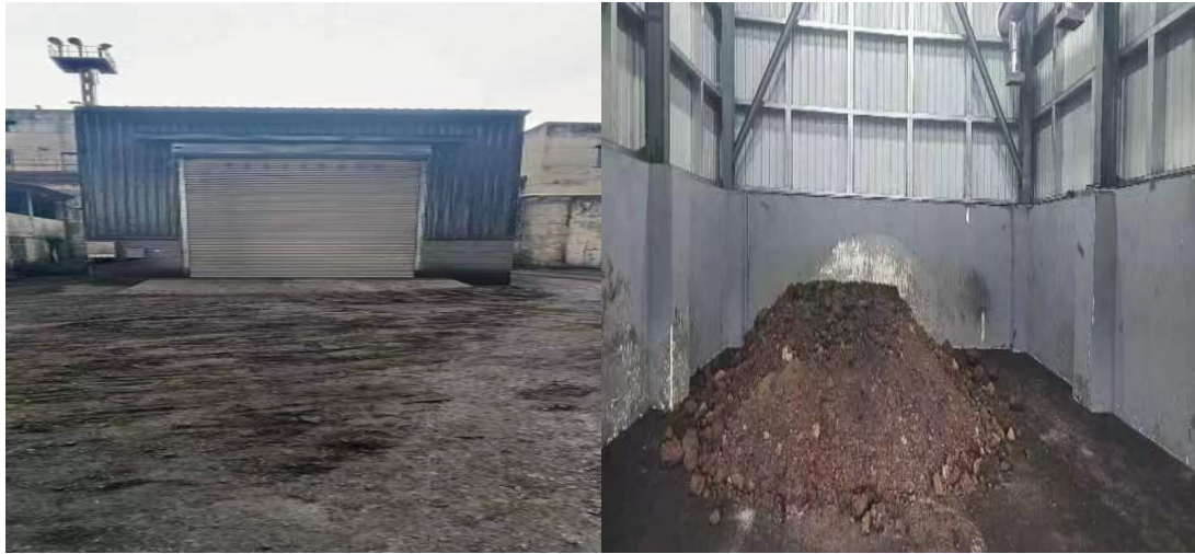
图4-1 应急污泥暂存库外观图4-2 应急污泥暂存库内观
