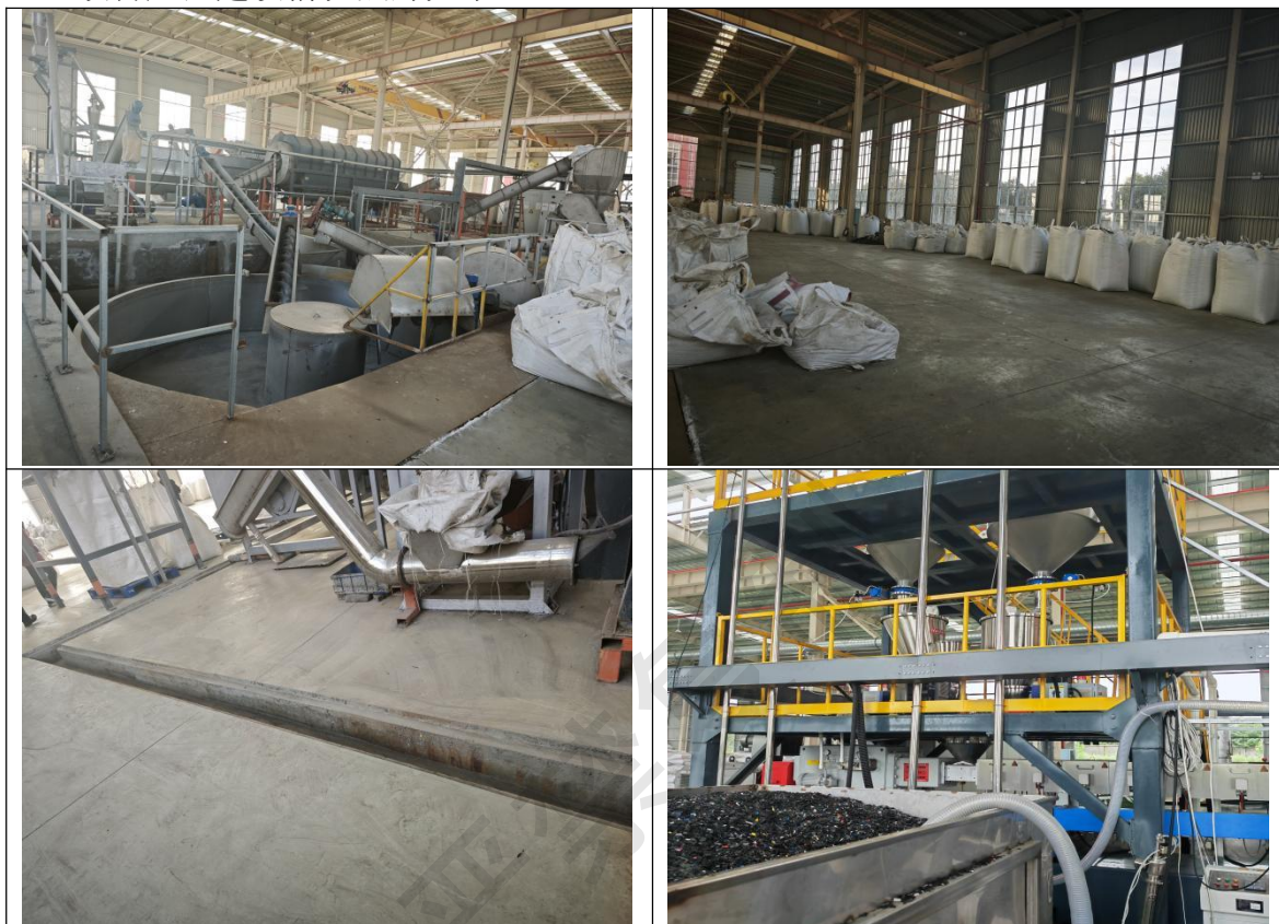
生产车间现状
