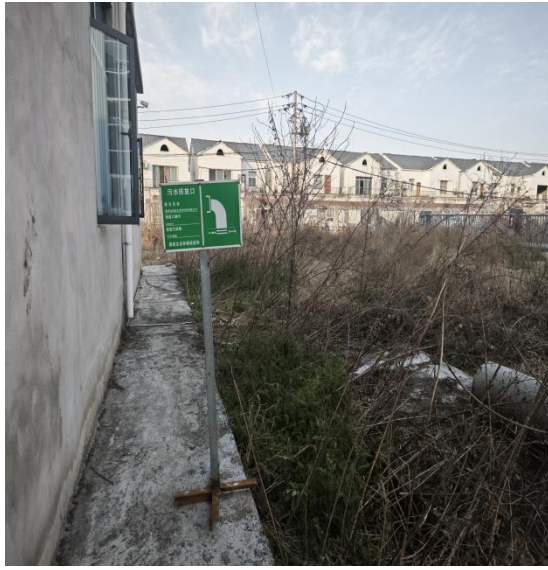
污水总排口标识牌
