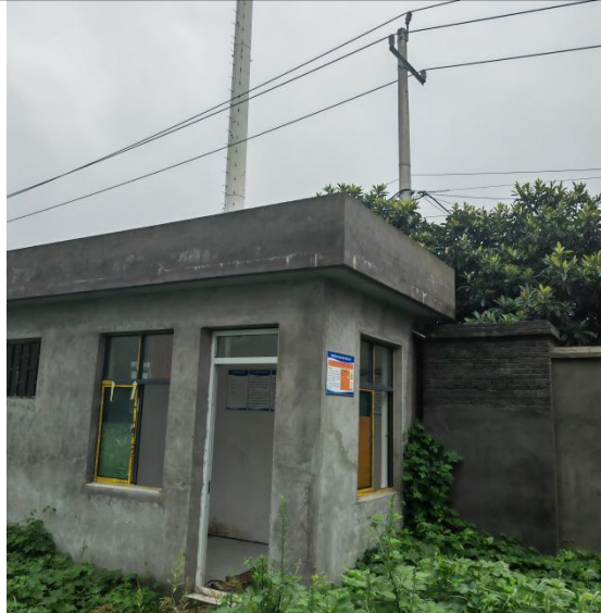
危险废物暂存间外观
