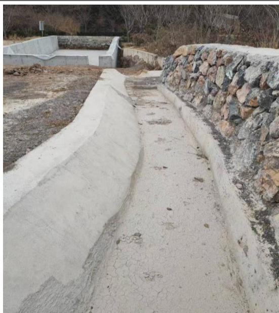
项目排水边沟
