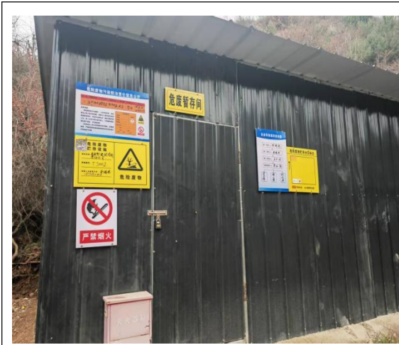
项目危废暂存间
