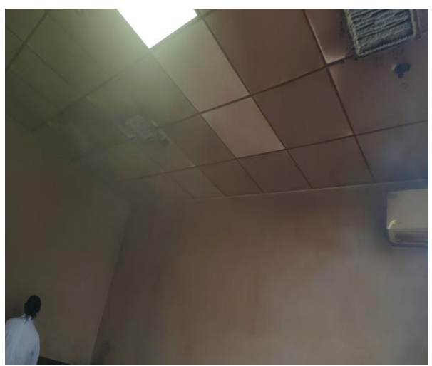
艾灸室排气扇
