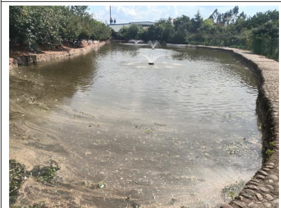
十三、初期雨水收集池
