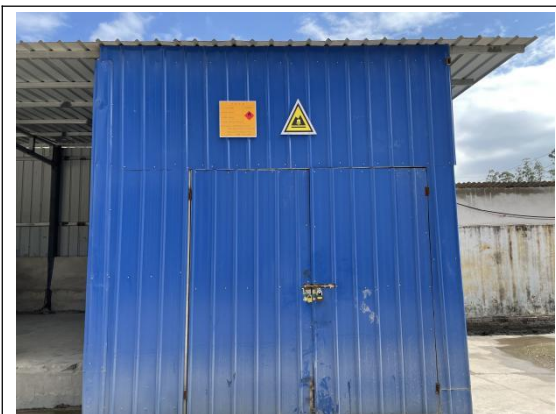
九、危险废物暂存间
