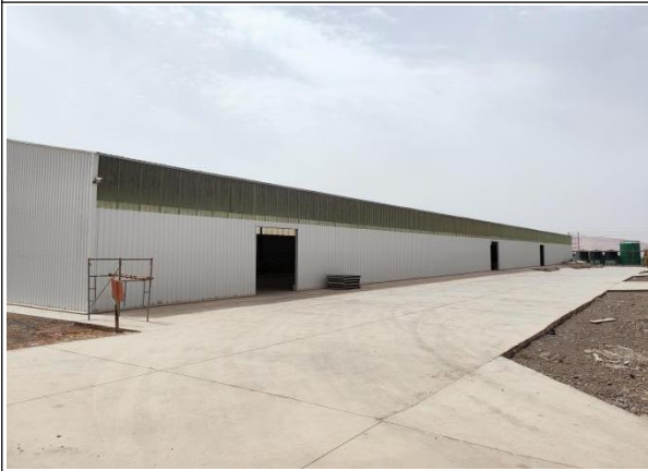
厂区道路硬化
