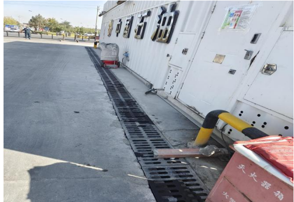
储罐加油机周边设应急导流槽
