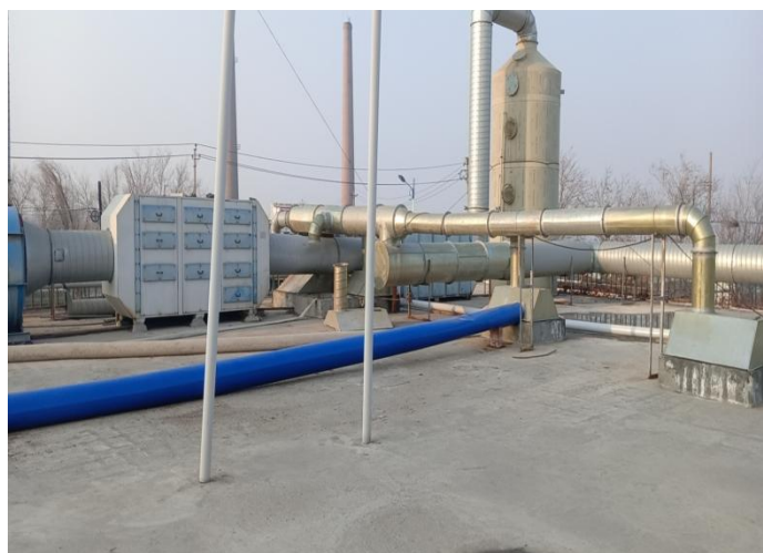
污水站离子（喷淋塔+活性炭环保箱 +UV 光氧一体机）除臭
