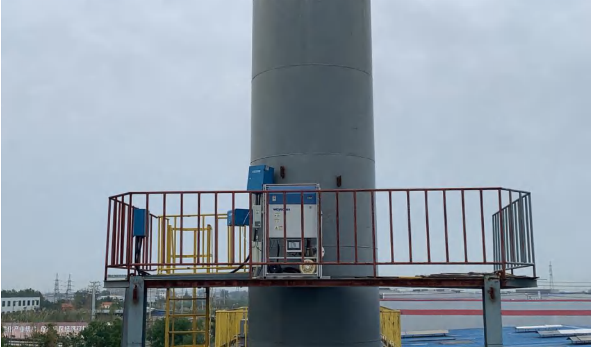
FQ2.FQ3 焚烧炉检测口与检测平台
