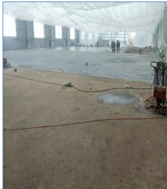
图3-2 发酵车间和原料库地面防渗工作
