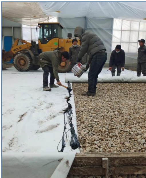
图3-2 发酵车间和原料库地面防渗工作
