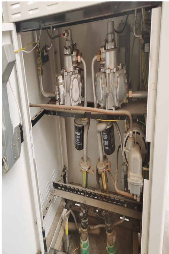
项目加油机油气回收装置
