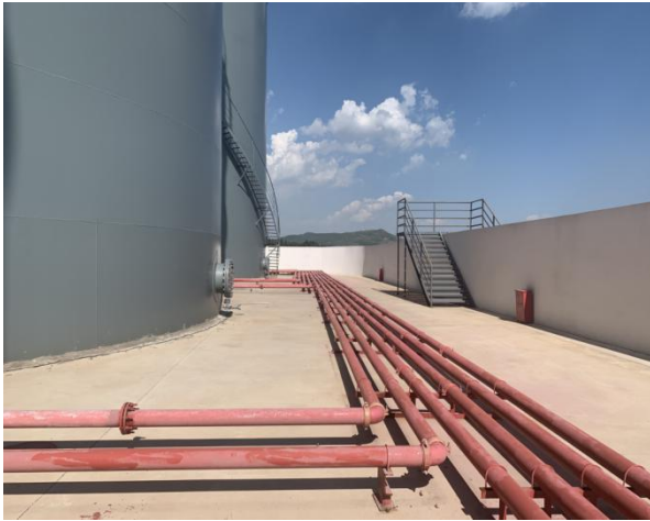
储油罐区域消防栓及围堰
