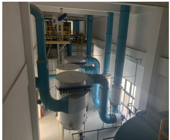
加工车间布袋除尘器及排气筒
