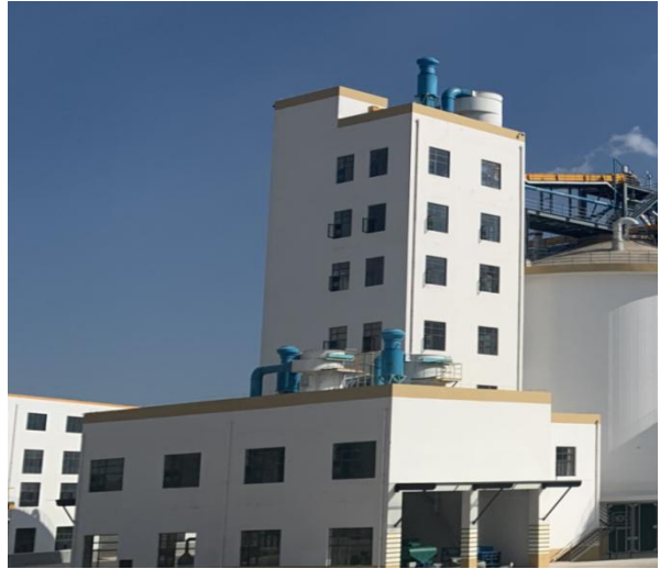
卸粮仓及提升塔布袋除尘器排气筒
