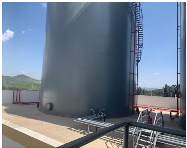
储油罐区围堰
