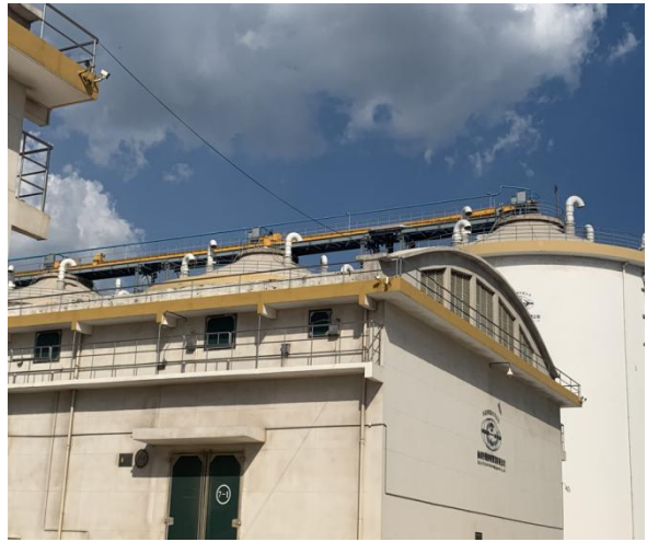
浅圆仓仓顶呼吸孔
