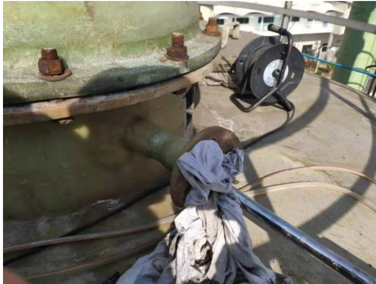
污水处理站除臭塔废气处理后排放口
