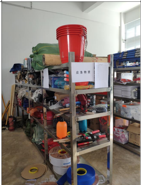
马厂升压站应急物资库房
