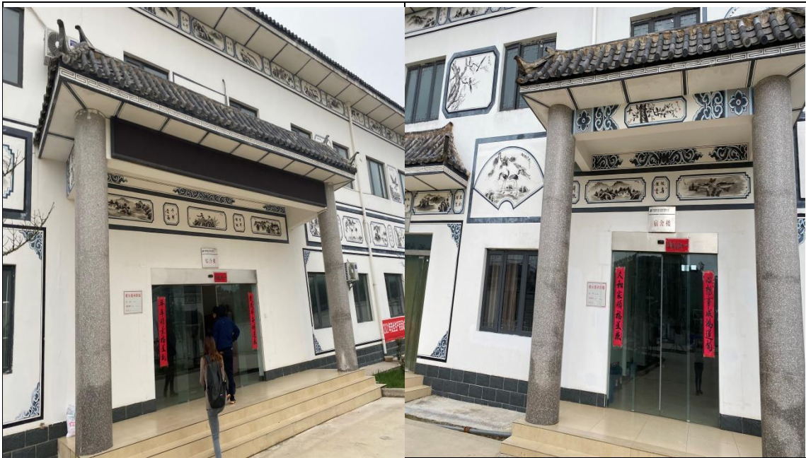
马厂升压站办公楼
