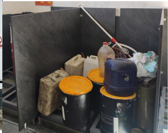
危险废物矿油暂存间（内部）
