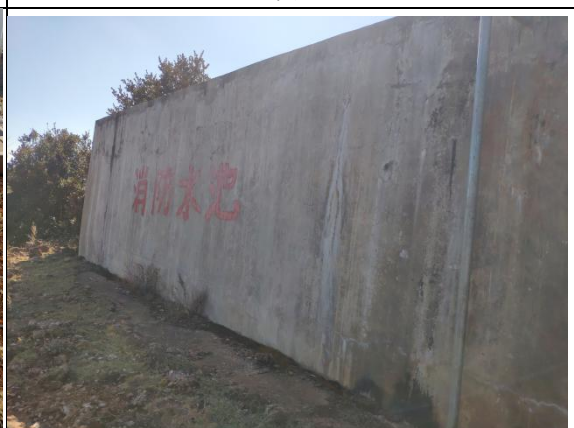
马厂升压站消防水池
