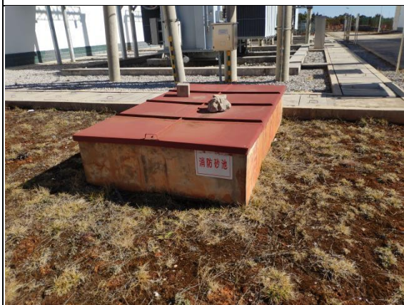
马厂升压站消防沙池
