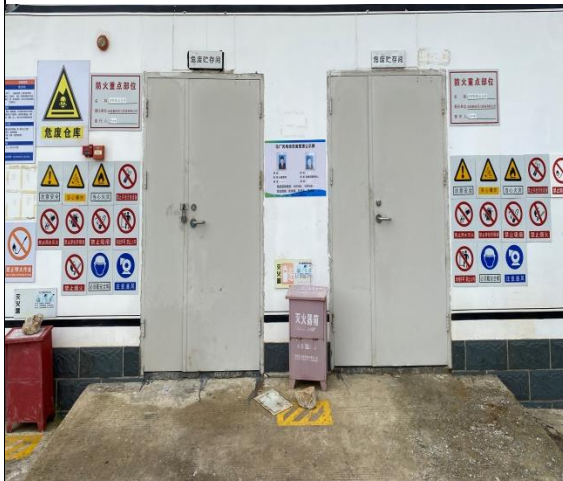
马厂升压站危废暂存间
