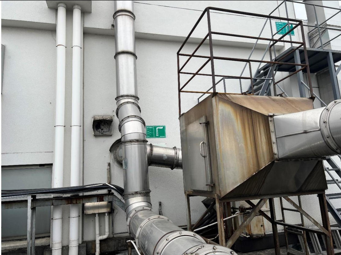
图 6 容器印刷废气治理措施图（气-1）
