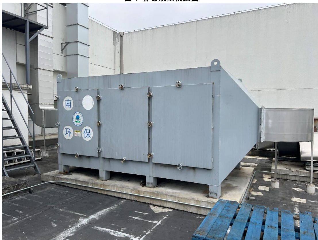
图 5 容器成型废气治理措施图
