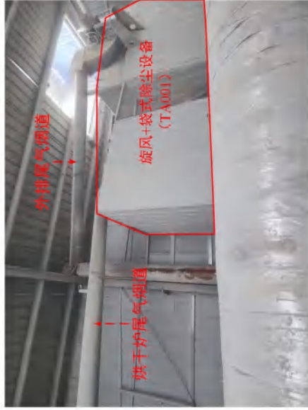
1、烘干炉尾气排气筒 (DA001) 及处理设备 (TA001, 旋风+布袋工艺)
