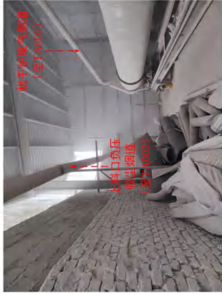
1、烘干炉尾气排气筒 (DA001) 及处理设备 (TA001, 旋风+布袋工艺)
