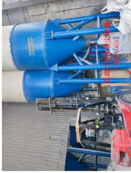
2、袋式除尘器 (TA002) 及制砂排气筒 (DA002)
