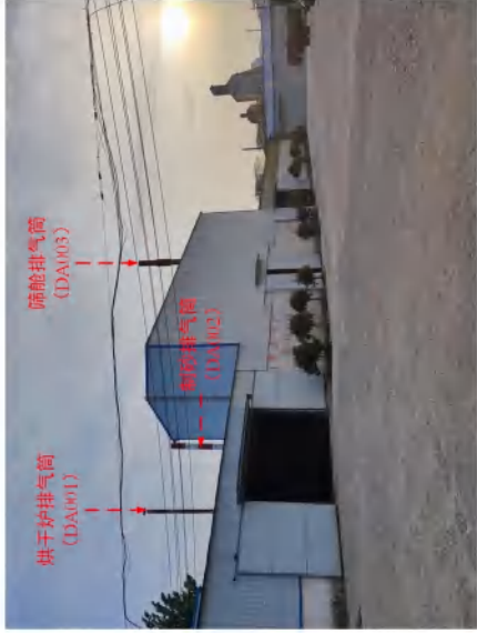
1、厂区硬化、厂房封闭 及项目排气筒分布与编号
