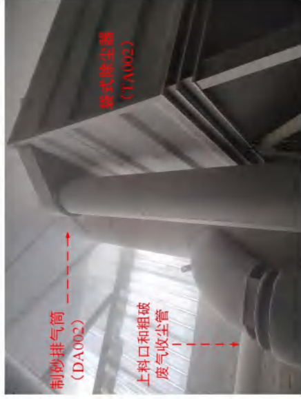
2、袋式除尘器 (TA002) 及制砂排气筒 (DA002)
