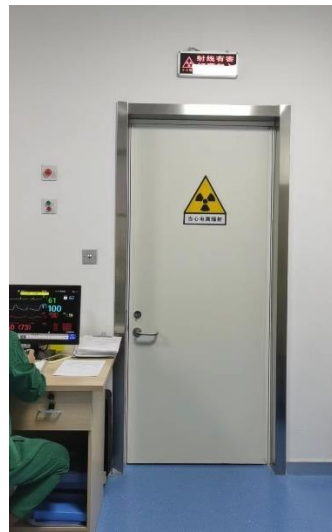
介入治疗中心 DSA 一室南侧控制室小防护门
