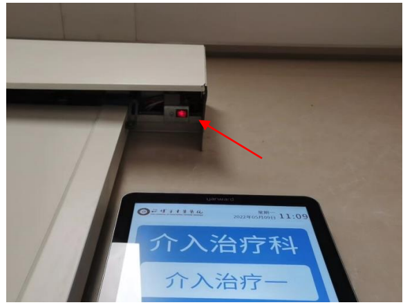
介入治疗中心 DSA 一室门灯联锁装置
